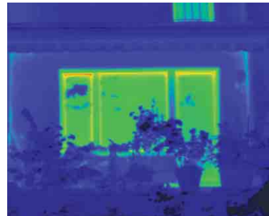
Nach dem sorgfältigen Einbau neuer Schüco Corona CT 70 Classic Fenster beweist die Thermografie den hohen energetischen Nutzen der Investition. Der ursprüngliche Energieverlust wird nahezu vollständig vermieden.
